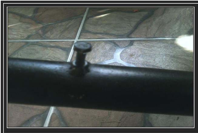
**Ilustración 2** *Detalle del tornillo incrustado en la torre, vista vertical*
