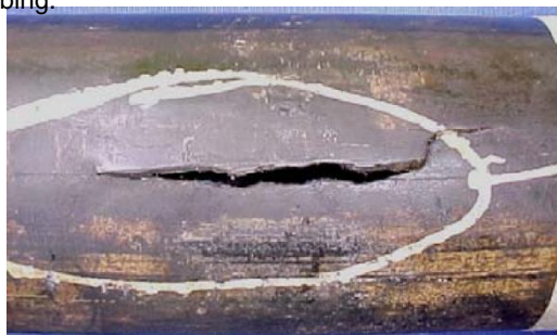
Figura 34. Grieta longitudinal presente en el tubing.
