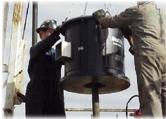
Figura 12. Inspección con WellTech en boca de pozo.
