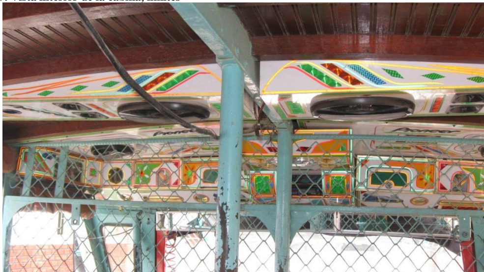
Figura 87. Vista interior de la cabina, límites
