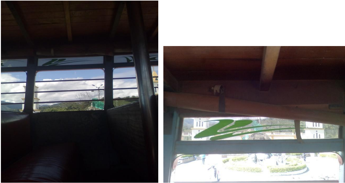
Figura 83. Vista diseño de las ventanas, parte interna de la cabina
