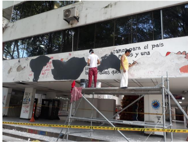
Figura 156. Fase de Instalación. Adaptación del muro. Aplicación de impermeabilizante (Pintura plástica). Lugar: Ágoras Usco.
