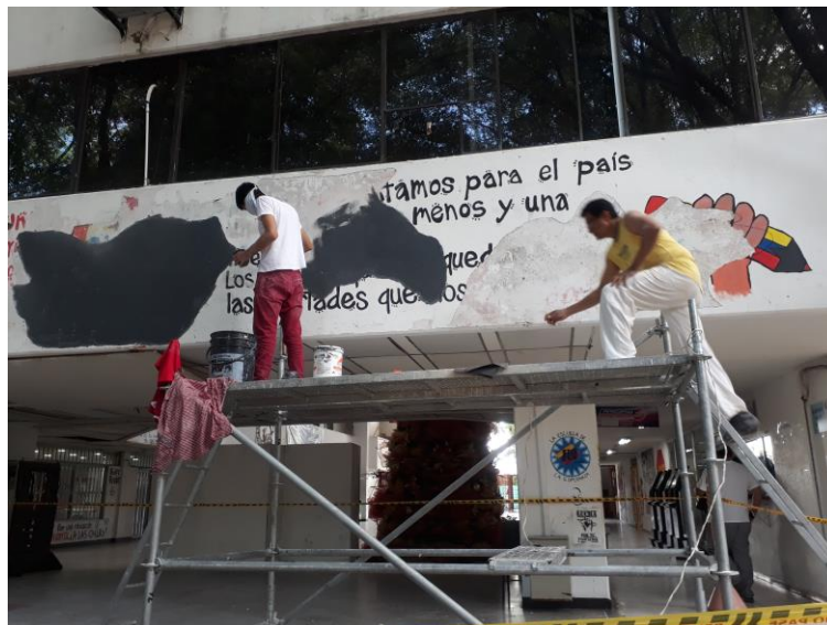
Figura 155. Fase de Instalación. Adaptación del muro. Aplicación de impermeabilizante
