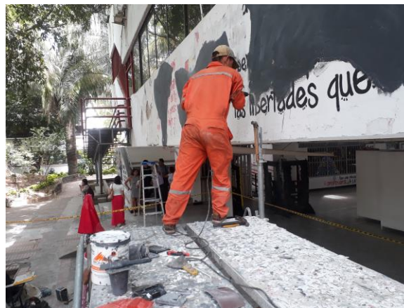
Figura 157. Fase de Instalación Adaptación del muro. Perforación del muro, para los Chazos expansivos. Lugar: Ágoras Usco.
