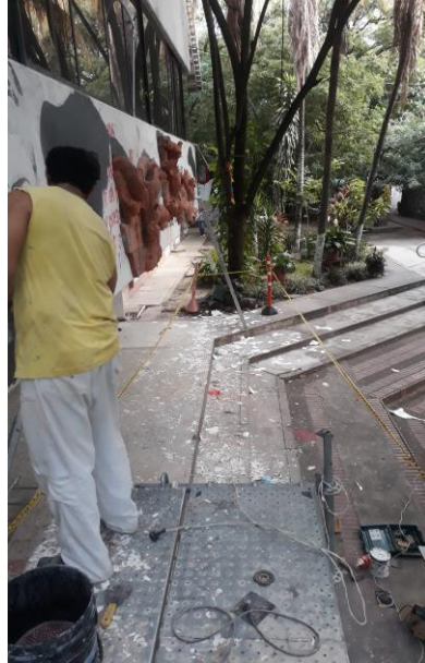
Figura 160. Fase de Instalación. Montaje de los fragmentos y láminas metálicas, con chazos expansivos. Lugar: Ágoras Usco.
