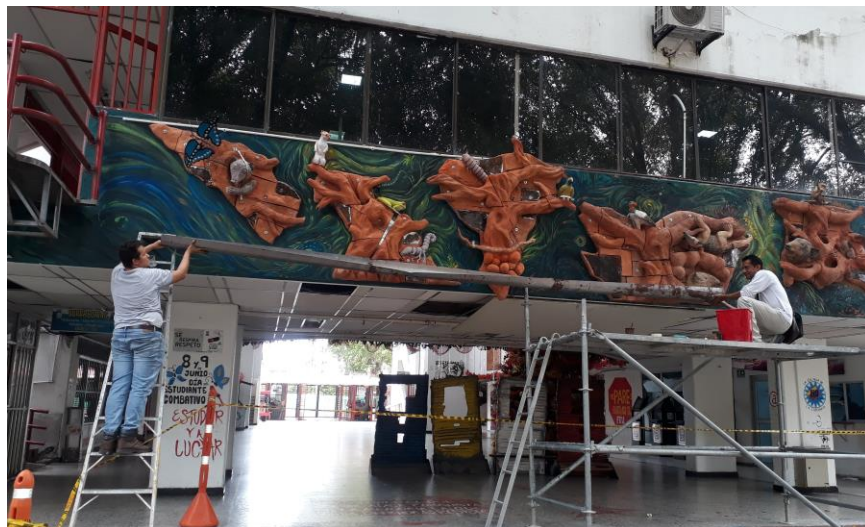
Figura 164. Fase de Instalación. Aplicación pictórica a piezas esculturas: animales. Lugar:
