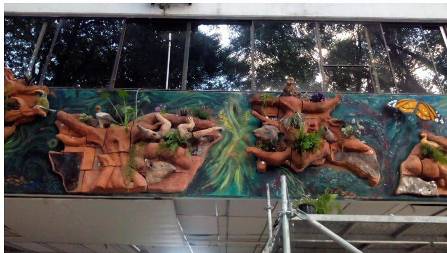
Figura 166. Etapa - Instalación. Ubicación y siembra de plantas (Jardín vertical). Lugar:
