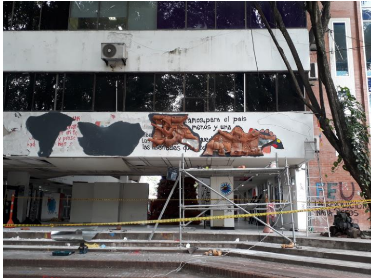
Figura 158. Fase de Instalación. Montaje de los fragmentos y láminas metálicas, con chazos expansivos. Lugar: Ágoras Usco.
