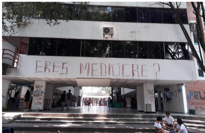
Figura 149. Fase de Instalación. Adaptación del muro. Como se encontraba el muro. Lugar:
