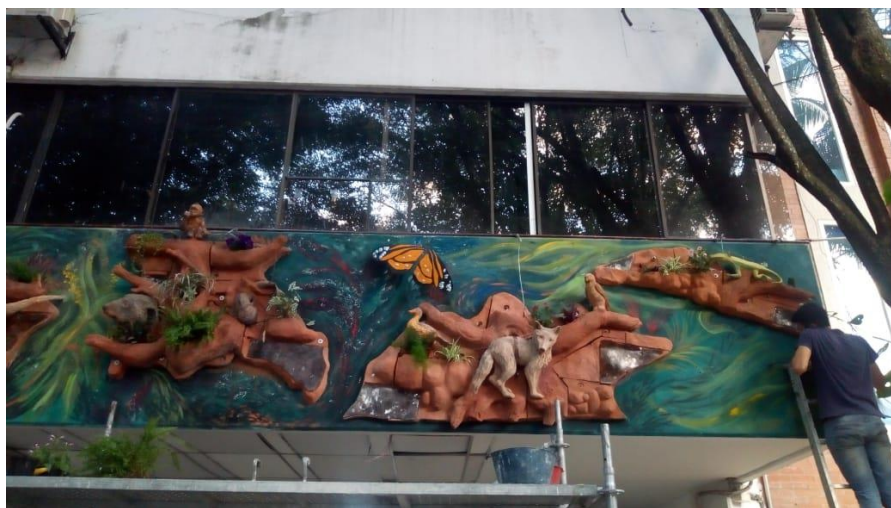
Figura 167. Fase de Instalación. Aplicación pictórica a los fragmentos y láminas de metal.
