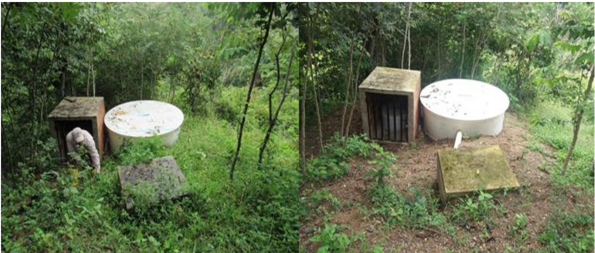
Figura 20. Antes y después, revisión instalación PTAR.
