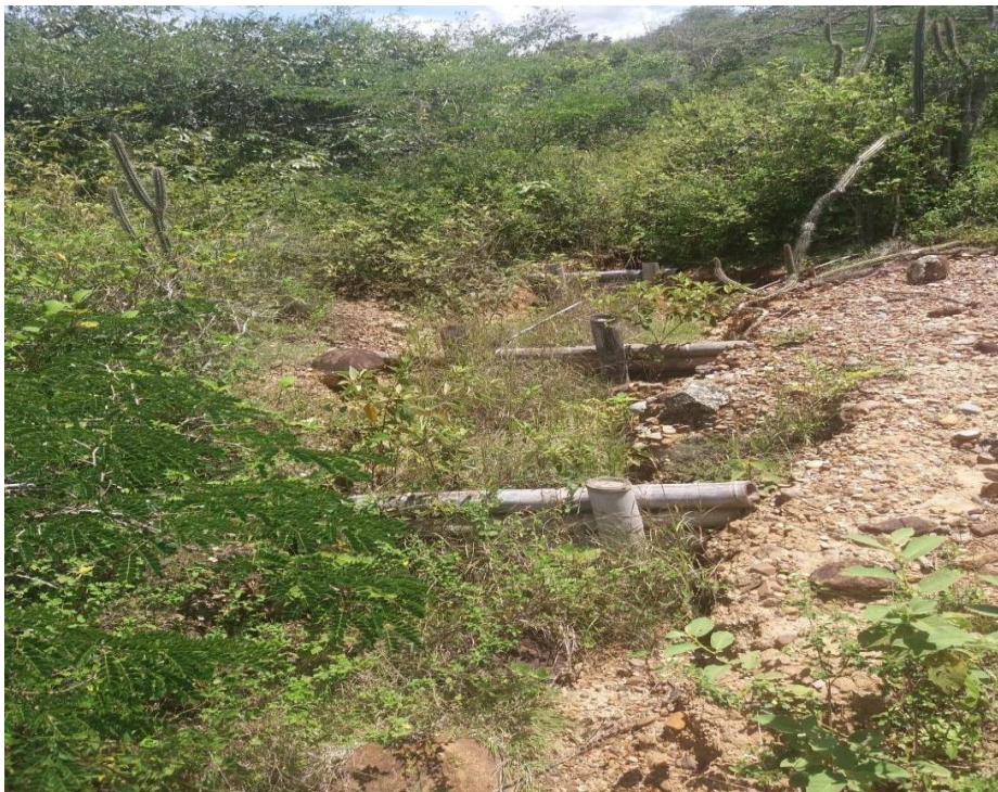
Figura 26. Cárcava mitigada por trinchos.
