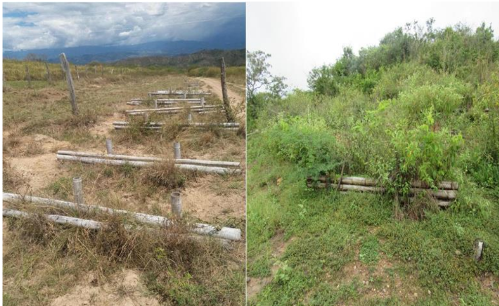
Figura 22. Trinchos y fajinas.
