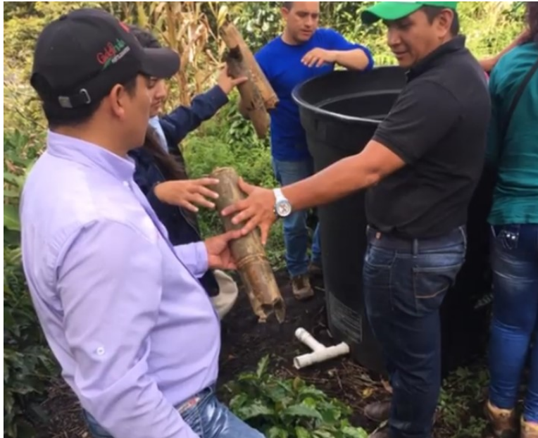
Figura 19 Llenado de reactor metanogénico con trozos de guadua.
