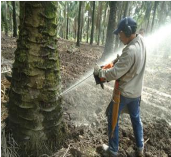
Figura 13. Perforación de palma para bloque 242 al 250.
