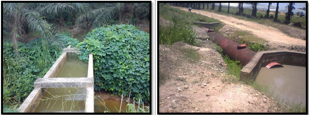
Figura 30. Obras de conducción y distribución.
