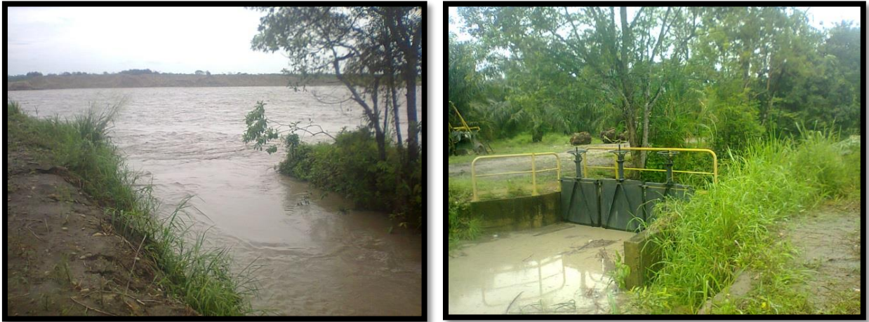
Figura 9. Entrada Lateral y Bocatoma Manuriba
