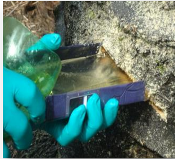
Figura 14. Aplicación de herbicida. bloque 242 al 250
