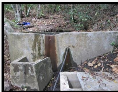
Esta estructura no cuenta con algún tipo de protección en la parte superior (tapas en concreto). Coordenadas geográficas: 3.34623, -75.35815 y altitud de 979 msnm.
