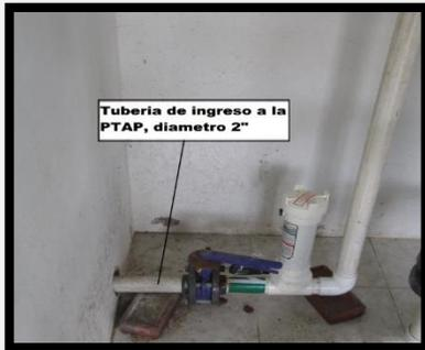
Se observa una tubería de 2" la cual transporta agua con floculos de gran peso y tamaño, estos al ingresar al sistema de filtración son retenidos en el lecho filtrante de flujo ascendente.
