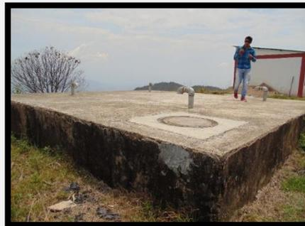
El tanque de almacenamiento de dimensiones (B\*A\*H) = (6\*6\*2.7) genera una capacidad máxima de almacenamiento de 97 [m] ^3. Cuenta con sus respectivos conos de ventilación en tubería de hierro de 3".
