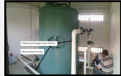
Se observa una tubería de 3" para el desagüe del lavado de filtros, y una tubería de 2", la cual transporta agua con floculos de gran peso y tamaño, estos al ingresar al sistema de filtración son retenidos en el lecho filtrante de flujo ascendente.
