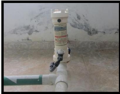
Dosificador Poot feeder modelo 320. Claramente se observa el dosificador solido por desgaste abrasivo tipo Poot feeder, utilizado para la adición de coagulante de Sulfato de Aluminio en pastillas y mezclando finalmente las sustancias por un tubo estático por inserción, el cual se dosifica en una tubería de 2” para posteriormente pasar a una tubería de 2” ubicada de manera vertical donde la válvula número 2 determina el paso del agua con el agente coagulante a la Minipack2.
