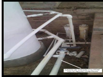
Claramente se observa el dosificador solido por desgaste abrasivo utilizado para la adición de coagulante de Sulfato de Aluminio en pastillas y mezclando finalmente las sustancias por un tubo estático por inserción, el cual se dosifica en una tubería de 2”.
