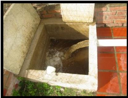
Como se puede observar la cámara de quiebre, reduce la presión del agua a 0 la cual se transporta por tubería de 3", después de su respectivo proceso en la PTAP hacia el tanque de almacenamiento.
