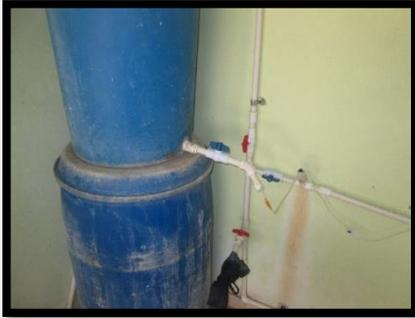
Se observa un sistema dosificador de solución por gravedad de carga regulable donde la sustancia utilizada son 1000 gr de hipoclorito granulado disueltos en un recipiente de capacidad de 100 litros de agua.
