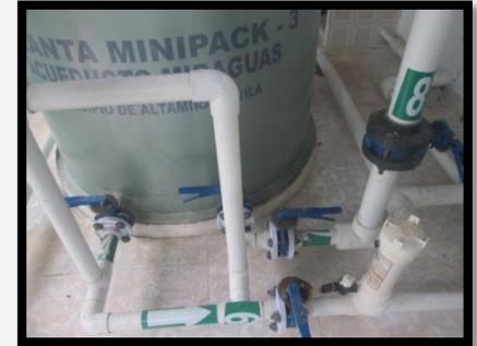
Se observa el sitio en la tubería de 2”, donde está ubicado el dosificador Sólido por desgaste abrasivo tipo Poot feeder Modelo 320.
