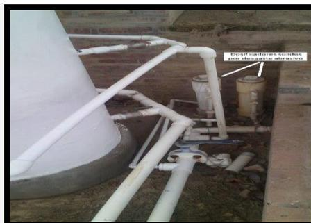
Dosificadores sólidos por desgaste abrasivo para el proceso de coagulación se encuentran en mal estado estos se mueven con facilidad y no están asegurados en la estructura.
