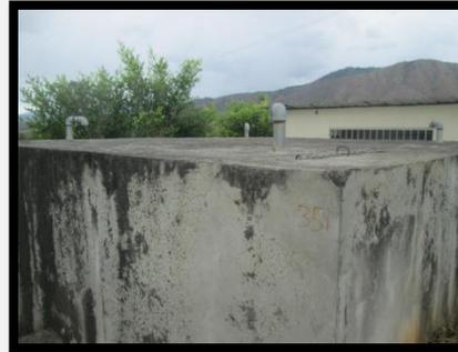
El tanque de almacenamiento tiene dimensiones de 5,5 metros de ancho, 5,5 metros de largo y 2,3 de profundidad, cuenta con sus respectivos conos de ventilación de 3”.
