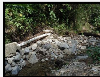
Daño en el encofrado del sistema de aducción comprendido entre la bocatoma y el desarenador. Longitud 2,5 m.
