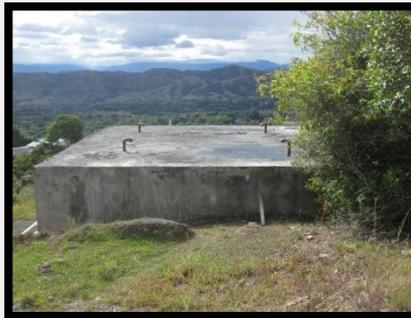
El tanque de almacenamiento tiene dimensiones de 8 metros de ancho, 8 metros de largo y 2,3 de profundidad, cuenta con sus respectivos conos de ventilación de 3".
