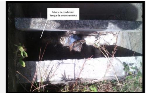
Se observa una tubería de 3” de diámetro la cual proviene por sistema bypass sin tratamiento alguno.
