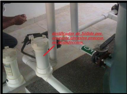
Se observa el dosificador sólido por desgaste abrasivo tipo poot feeder, modelo 320, para la desinfección hipoclorito sólido en pastillas cantidad aplicada 200 gr semanal.
