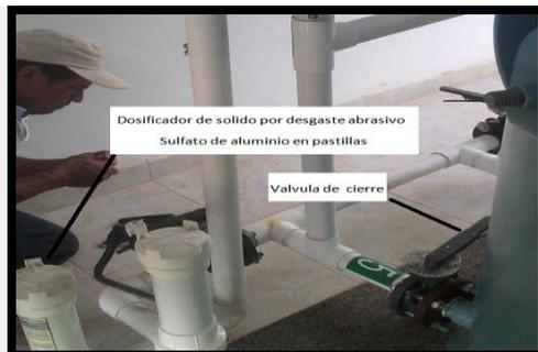
Dosificador sólido por desgaste abrasivo tipo Poot feeder, las válvulas apertura y cierre se encuentran en mal estado.
