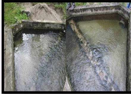
Se observan las dos tuberías de 10" que ingresan al desarenador, las cuales regulan el caudal de ingreso del agua, a través de las 2 válvulas tipo cortinas ubicadas en la cámara recolectora del desarenador.
