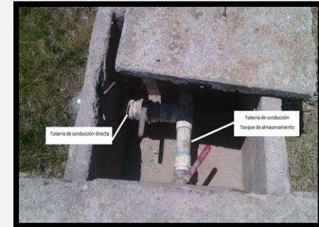
Se observa una tubería de 3" de diámetro la cual proviene del sistema bypass y (PTAP) esta viene sin tratamiento alguno debido al daño en una de las válvulas en la (PTAP)
