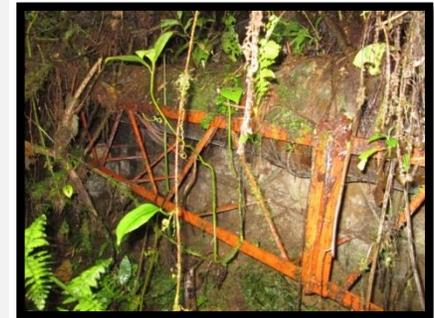
Se Observa la bocatoma de fondo, la ubicación de las rejillas de dimensiones de 1,40\* 0, 50 m y la cámara recolectora la cual tiene una tubería de lavado de 12" y una tubería de aducción de diámetro 12", RDE 41 de longitud de 100 m al desarenador, esta cámara no presenta agrietamiento, ni
