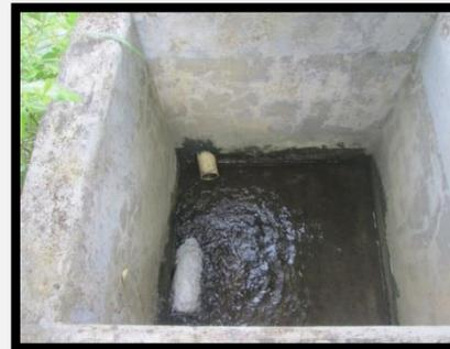
Esta cámara se utiliza para el sistema de lavado de filtros y para aforo de caudal de la PTAP, cerrando la llave al tanque de almacenamiento y abriendo la llave del lavado filtros.
