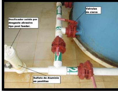
Dosificador soldado por desgaste abrasivo tipo Poot feeder, las válvulas de cierre o corte, la PTAP está dentro de la caseta de operaciones.
