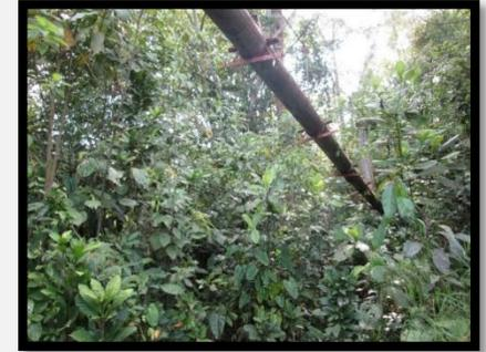
Longitud 30 m, transporta tubería de 8" RDE 41.
