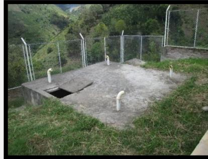
El tanque de almacenamiento tiene dimensiones de 4 metros de ancho, 4 metros de largo y 3 de profundidad, cuenta con sus respectivos conos de ventilación de 2".
