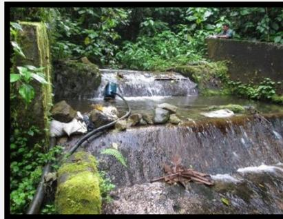
Coordenada geográfica N 02°18'53, 44" W 75°28'25.57". Tubería en Viaducto de 12" PVC en RDE 41, longitud de 100 metros desde la bocatoma hasta desarenador. Los 20 m de tramo en viaducto se encuentran totalmente cubiertos de moho en todas las superficies por las condiciones climáticas de alta humedad en la región, lo que podría generar daños estructurales en la tubería.
