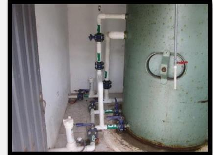
Las válvulas de cierre o corte de la salida del sistema de filtración de flujo descendente, la PTAP está dentro de la caseta de operaciones.
