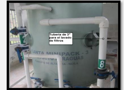
Tubería de 3” la cual transporta el agua del lavado de los filtros.
