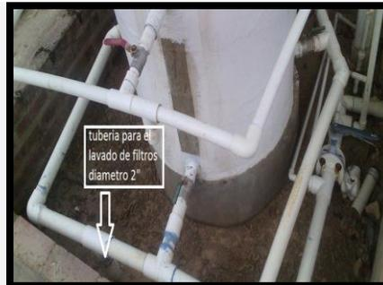
Sale con tubería de 2 pulgadas al tanque de almacenamiento su válvula de cierre y apertura se encuentran en óptimas condiciones para presentar un buen servicio.
