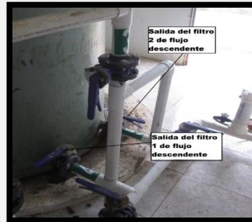
Se observan las salidas del agua (filtrada) de los 2 filtros de flujo descendente.
