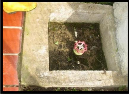
Se observa claramente una válvula de cierre y apertura tipo cortina, la cual regula el ingreso del agua por tubería de 3" a la PTAP.
