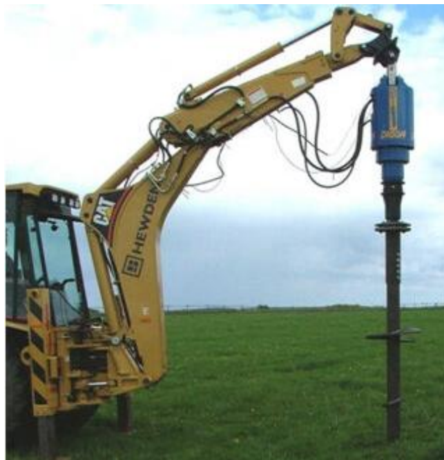
Figura 2-2 Instalación de pilotes helicoidales. Tomado de Tectónica (s.f)
