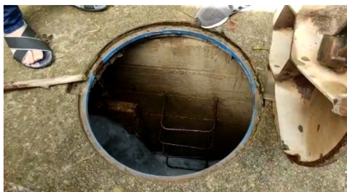
Figura 6. Cámara de recolección secundaria.
