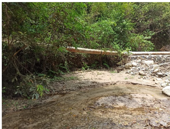
Figura 19. Prolongación tubería 10" suspendida en el aire.
