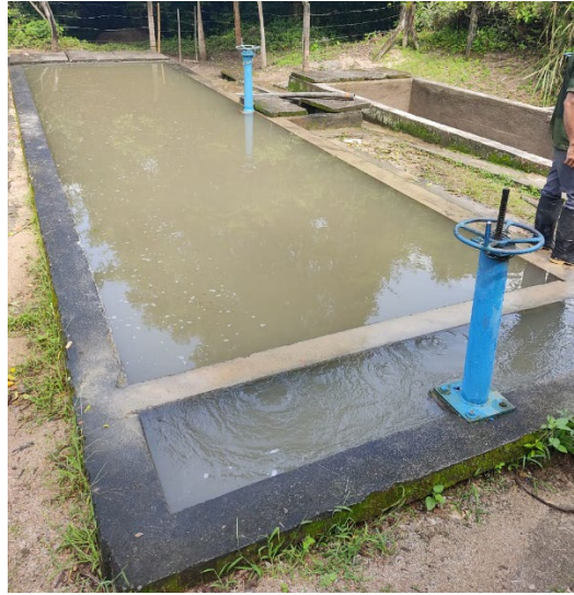
Figura 12. Desarenador 1.
