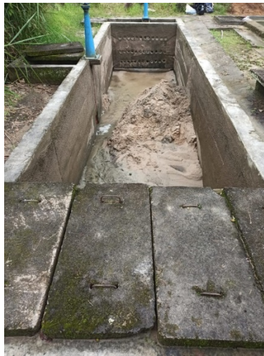
Figura 13. Desarenador 2.
