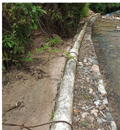
Figura 20. Tubería apoyada en gaviones con anclajes.
