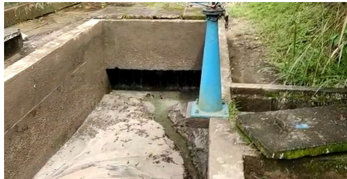
Figura 16. Válvula de lavado y mantenimiento desarenador 2.
