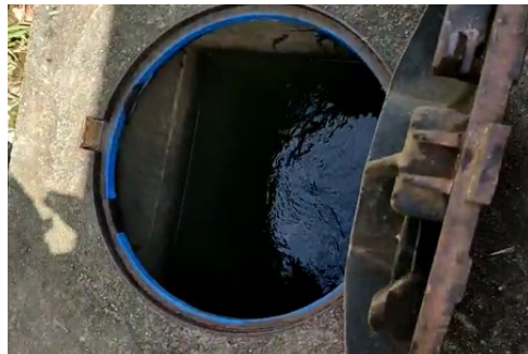
Figura 9. Tercera cámara de vertedero.
