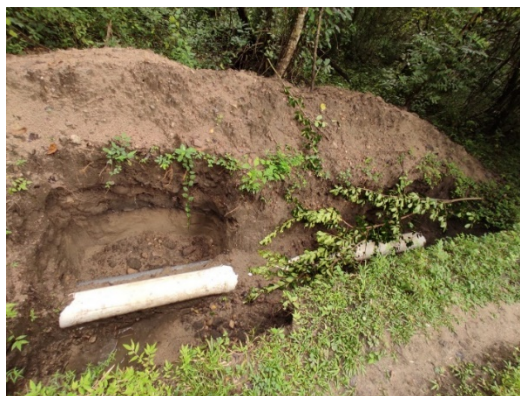
Figura 22. Apique encontrada tubería de conducción 10".
