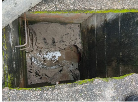
Figura 14. Cámara de recolección aguas lluvia y de desarenador 1.
