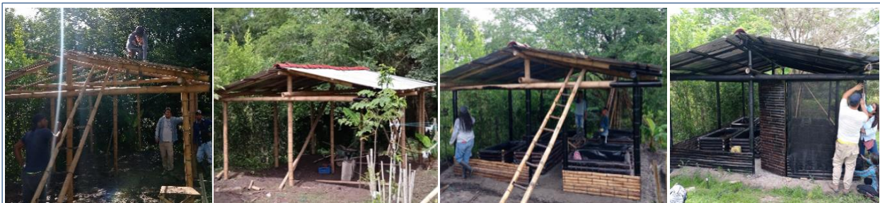
Figura 13. Construcción de biofabrica
