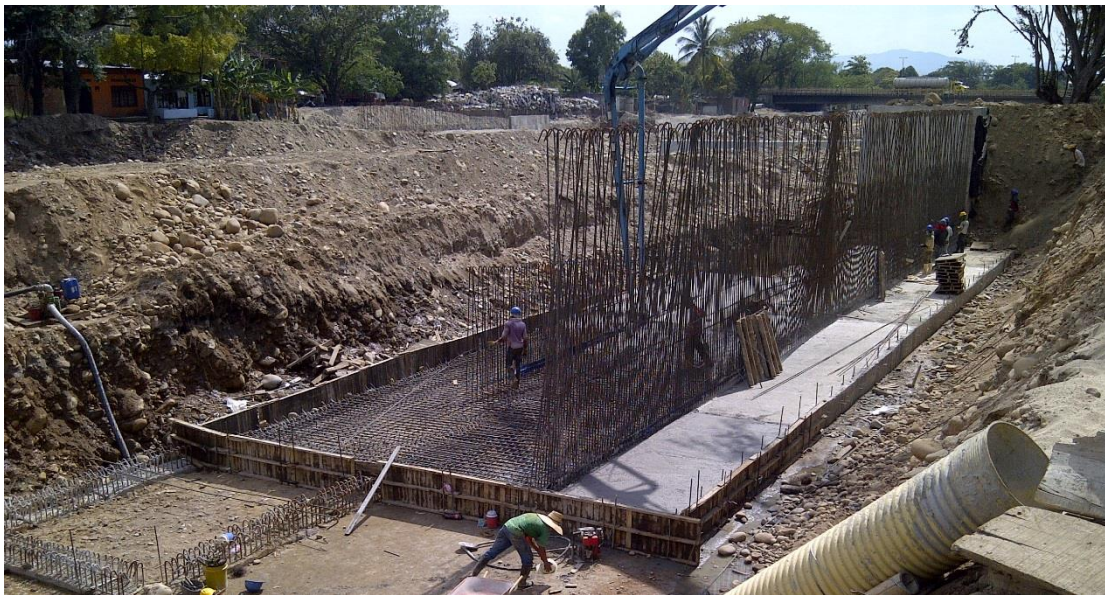
Imagen 2: Construcción de rampa #3. Fundida de concreto para la zarpa.
