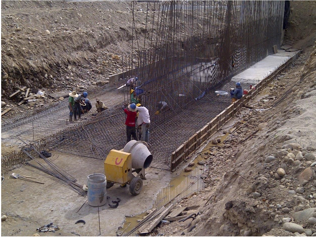
Imagen 1: Construcción de la rampa #3. Amarre de hierro y formaleta.
