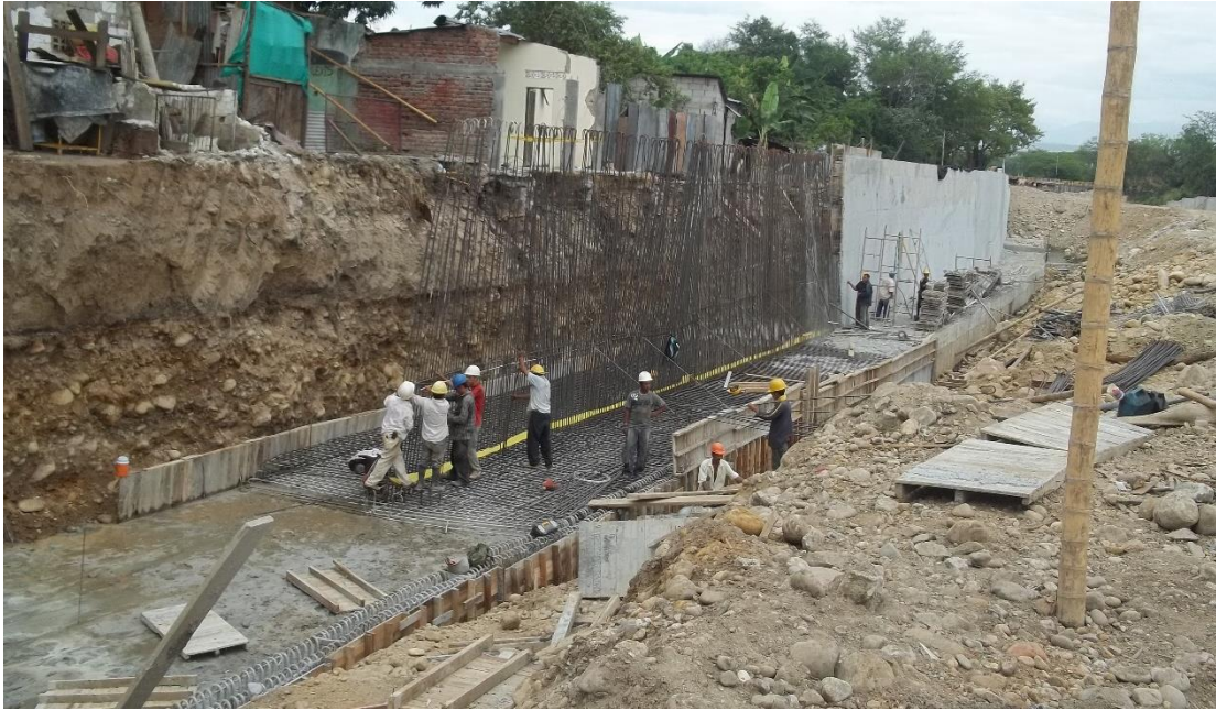
Imagen 1: Construcción de muro de H= 6,0 mts en margen izquierda. Amarre de hierro para zarpa y vástago
