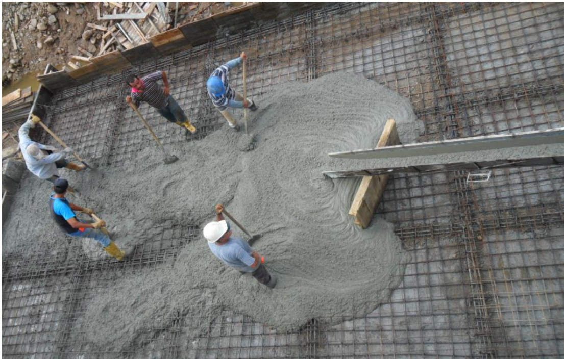
Imagen 2: Placa plataforma inferior rampa #4. Fundiendo concreto para placa
