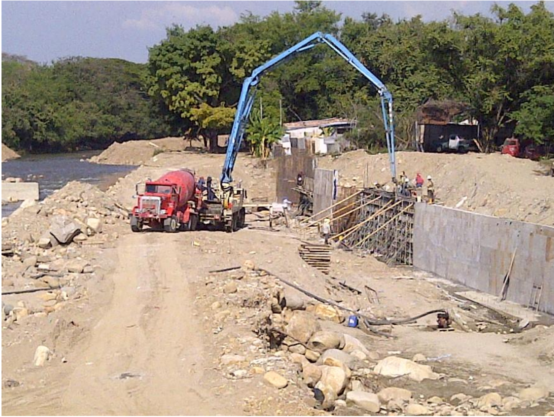
Imagen 3: Fundida de concreto para vástago muro de H=4,5 mts
